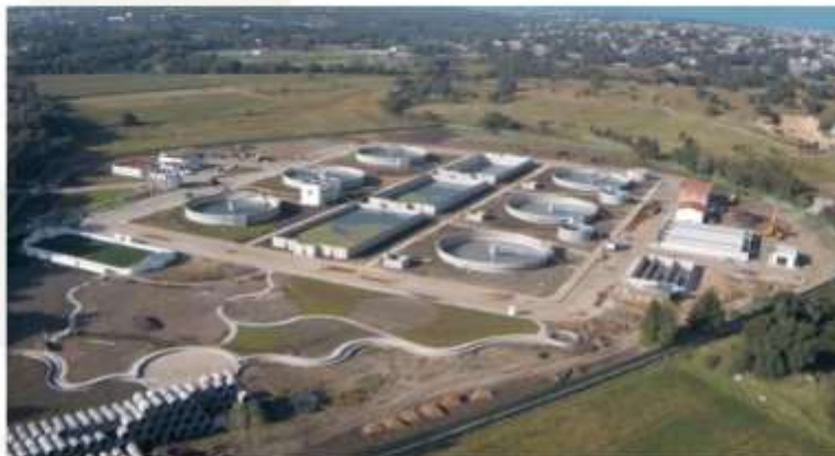
Imagen 1. Planta de tratamiento de Agua "Presa de Guadalupe"
