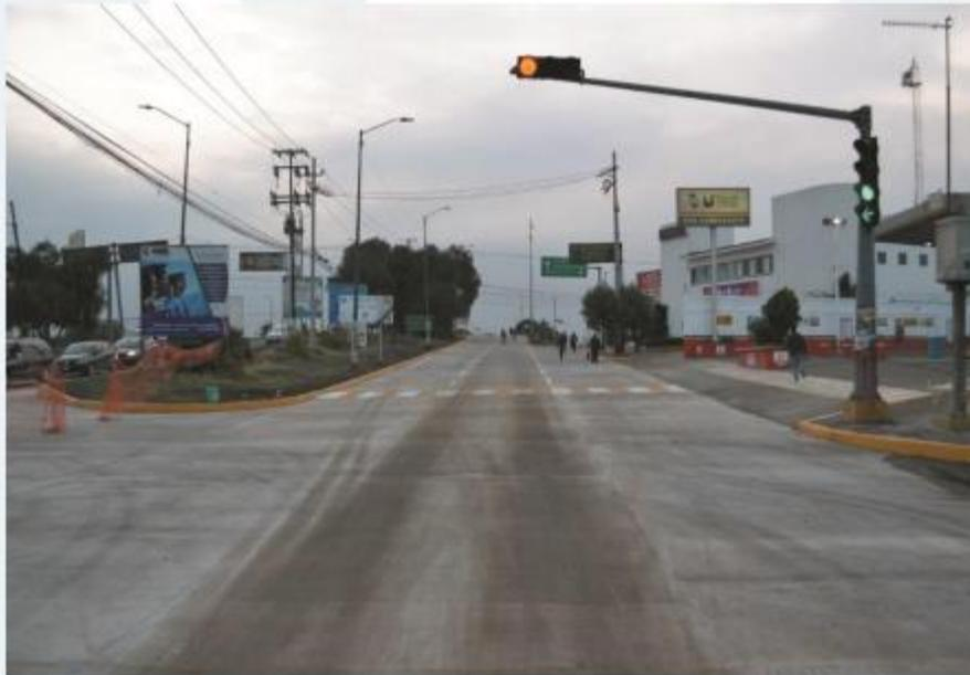
Repavimentación con concreto hidráulico del Acceso Nor-Poniente y cruce de Av. Chalma
